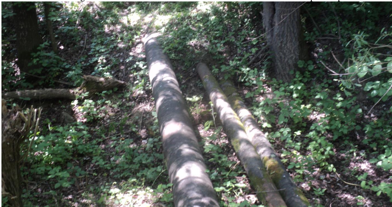
Foto 1 și 2 - Imagini cu conductă de titei Ø10 3/4" F1 Barbatești - Orlești decoperțate pe traseu.
